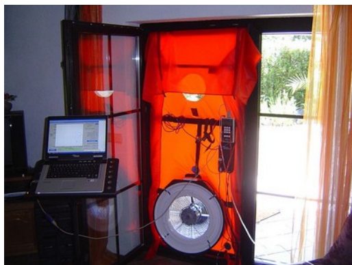
BlowerDoor: Quelle: Bauthermografie & Luftdichtheitsprüfung Lutz Weidner / Thüringen
